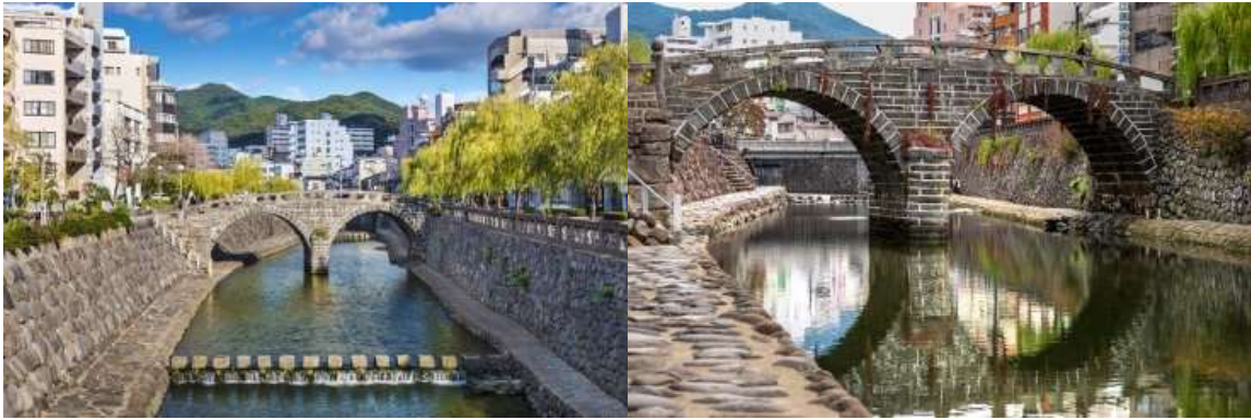
สะพานเมกานะบาชิ (Meganebashi Bridge)
